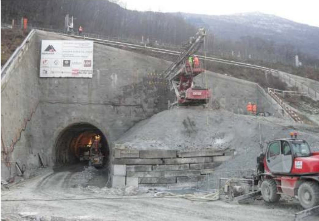
Sonda SR510 in lavorazione sulla calotta superiore
