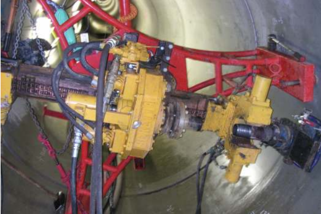
Attrezzatura di perforazione montata su supporto leggero
