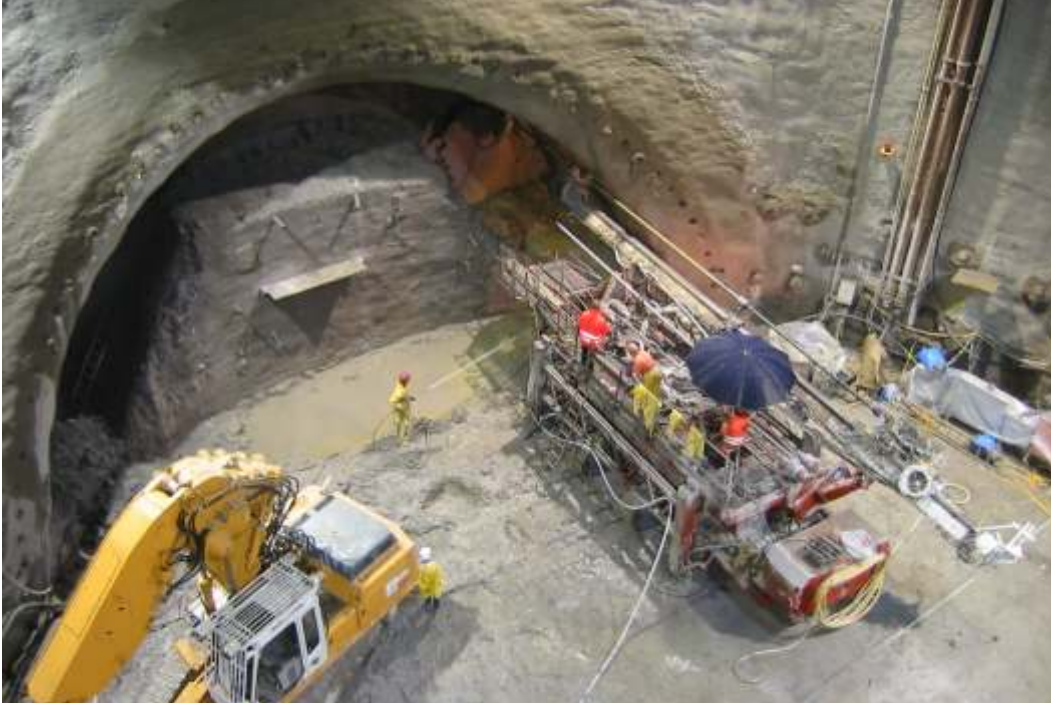
Sonda SR510 in lavorazione nel pozzo d'attacco
