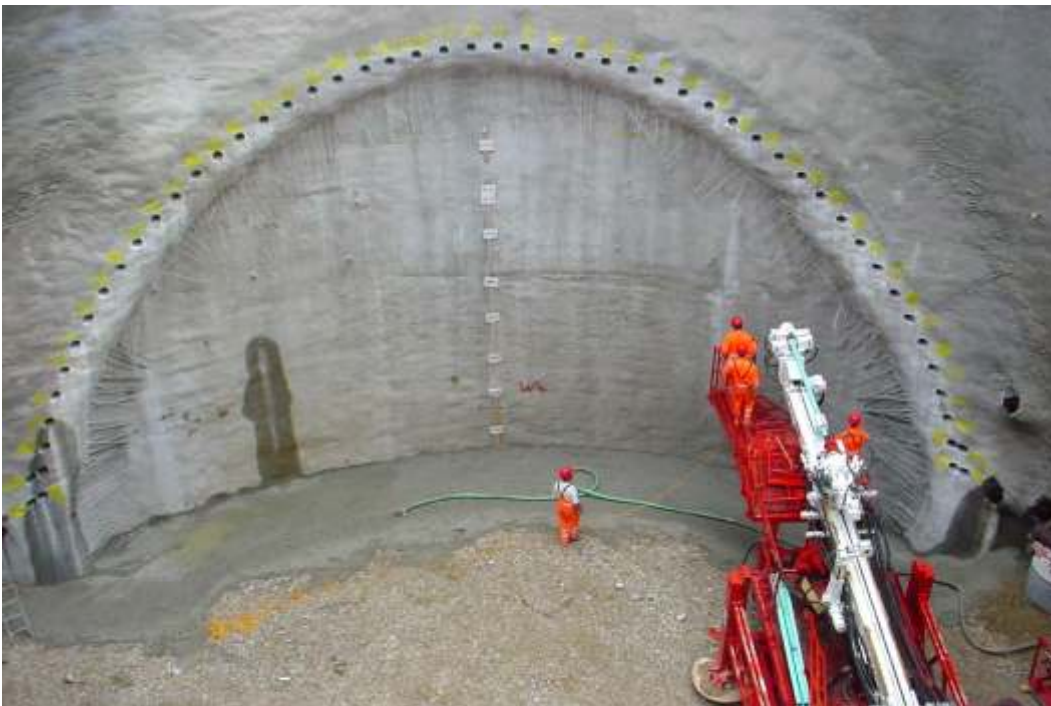
Sonda SR510 in lavorazione nel pozzo d'attacco
