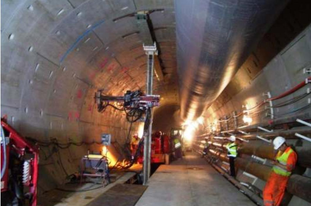
Sonda perforatrice montata sul mast verticale
